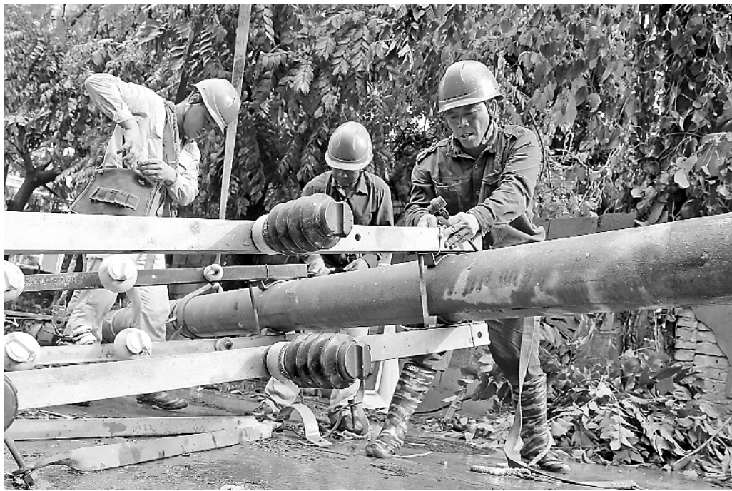
11日,浦城县供电公司共产党员服务队在高岭镇圆盘村重新立杆架线。当天15时50分,圆盘村一棵25米高大树受台风影响,连根拔起压到10千伏双回线上,扯断电杆。浦城县供电公司立即组织共产党员服务队开展抢修工作,当晚7时恢复该线路供电。(李义友 袁野 叶凌云 摄)
