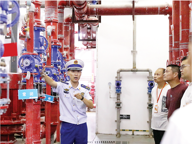
消防宣传骨干讲解水泵房设备运行原理 (郑振盛 摄)
