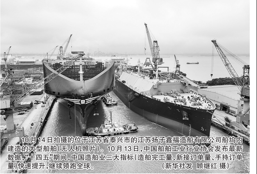
10月14日拍摄的位于江苏省泰兴市的江苏扬子鑫福造船有限公司船坞内建造的大型船舶（无人机照片）。10月13日，中国船舶工业行业协会发布最新数据，“十四五”期间，中国造船业三大指标（造船完工量、新接订单量、手持订单量）快速提升，继续领跑全球。（新华社发 顾继红 摄）
