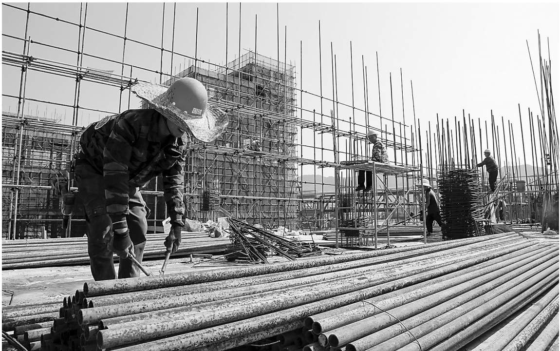
13日,顺昌县金山新材料产业园福建中鑫新材料有限公司“年产3700吨精细化学品”项目建设现场,施工人员在忙碌着。该项目占地约28.3亩,总投资超1.7亿元,投产后将实现产业链的延伸。(朱城铖 朱宇 摄)
