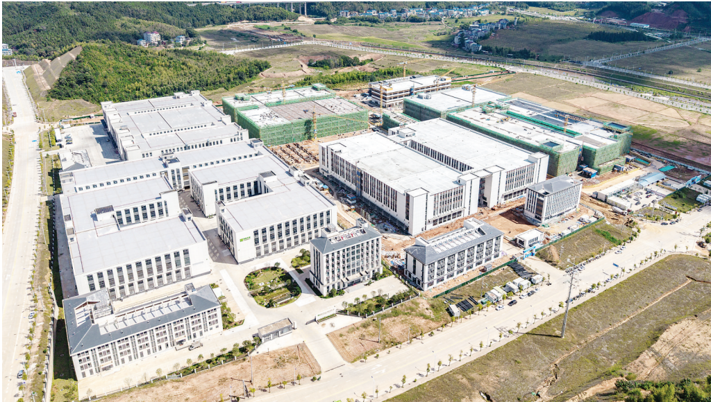
这是近日拍摄的建阳经济开发区标准化厂房及配套基础设施项目现场。该项目总投资11.6亿元,占地163亩,总建筑面积约19万平方米,建安投资5.5亿元,主要建设多层定制标准厂房、综合楼、仓库、办公楼、宿舍楼等,项目建成投产后将进一步扩大建阳医卫材料产业集群规模。(朱宇 方诗琦 刘立杰 摄)
