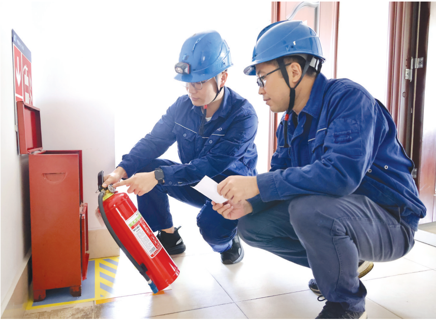
近日,华电南平能源公司紧紧围绕“全民消防、生命至上——安全用火用电”主题,将消防宣传月活动与安全大检查相结合,开展人员密集场所消防隐患排查整治行动,组织消防知识技能培训 and 应急演练,织密消防安全防护网。图为企业管理人员对消防器材进行检查。(林望阳 摄)
