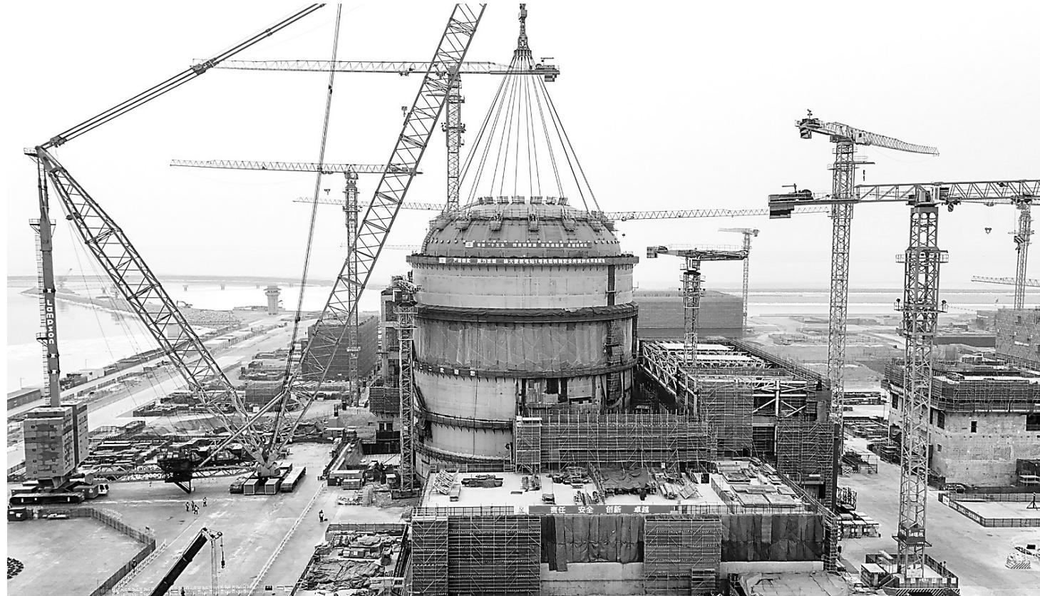
2月10日拍摄的徐大堡核电站1号机组核岛钢制安全壳顶封头吊装作业现场(无人机照片)。
