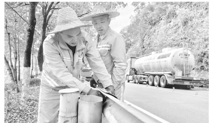
日前,公路养护人员在修复国道上的护栏。近期,建瓯公路部门全面开展汛期安全隐患排查治理工作,对辖区内国省干线公路沿线高陡边坡、安防设施、排水系统、桥涵构造物等关键部位开展检查,保障群众出行安全顺畅。(钟云飞 钟建业 摄)
