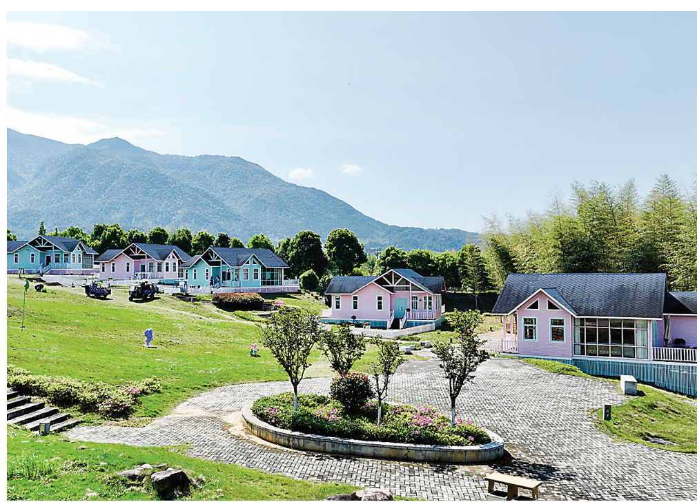
日前，邵武世遗一号风景道樱花小镇景区启动整体更新提质工程，通过打造特色主题木屋、丰富文旅业态、完善配套设施等举措，加快从观光型景区向高品质度假型景区转型，提升文旅服务品质与游客体验感。目前，6栋主题木屋群已完成装修改造3栋。图为景区改造现场。
