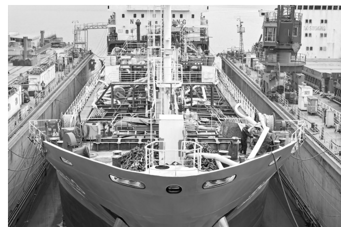
4月27日，在江苏省连云港鸿云实业有限公司生产基地，一艘船舶正在建设中(无人机照片)。当日，国家统计局发布数据显示，1至3月份，全国规模以上工业企业实现利润总额16960.4亿元，同比增长15.5%。(新华社发 王春摄)
