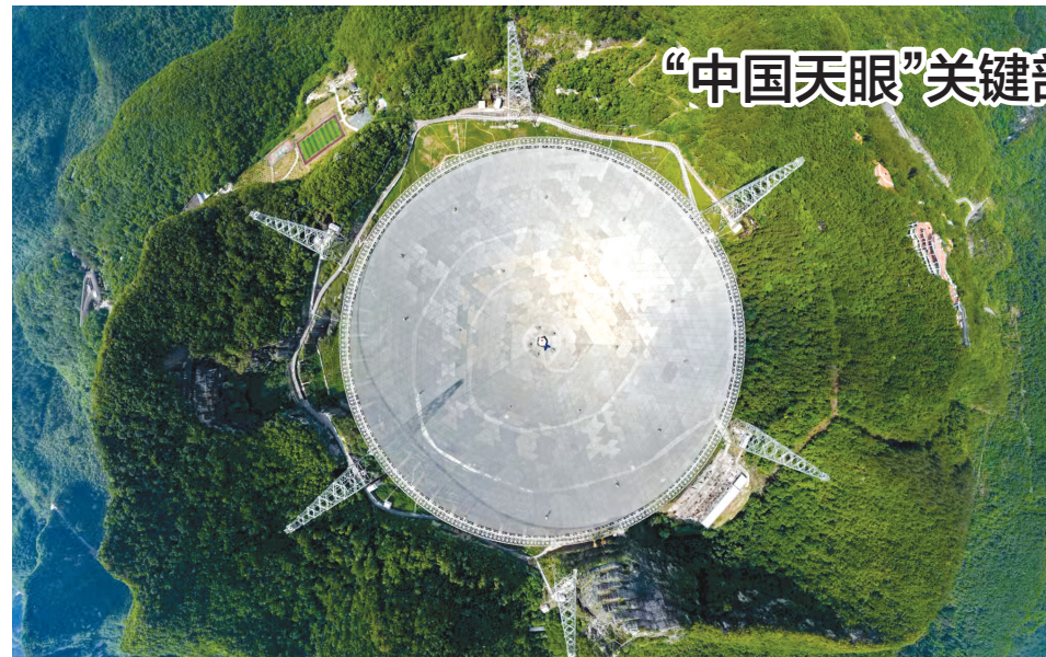
5月7日拍摄的“中国天眼”全景(无人机全景照片，维护保养期间拍摄)。
