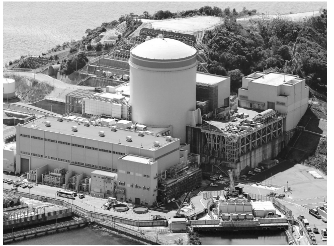
这是2025年3月14日在日本福井县拍摄的关西电力公司美浜核电站3号机组(资料照片)。据日本共同社报道,位于日本福井县的关西电力公司美浜核电站3号机组5月8日凌晨因蒸汽泄漏而暂停运转。(新华社/共同社)
