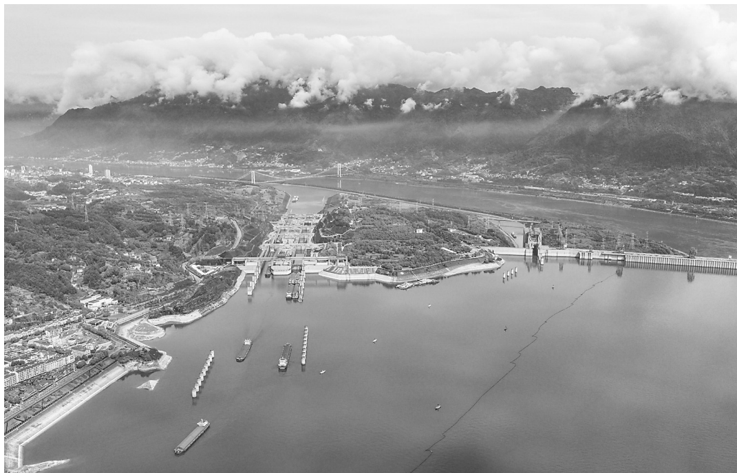
5月13日,在湖北宜昌,船舶有序通过三峡双五级船闸(无人机照片)。 据中国三峡集团消息,自2025年11月21日启动枯水期补水调度以来,截至5月12日,三峡水库已累计为长江中下游补水超100亿立方米,为长江中下游沿线民生供水、农业生产、航运畅通及生态保护提供了坚实保障。(新华社发 郑家裕 摄)
