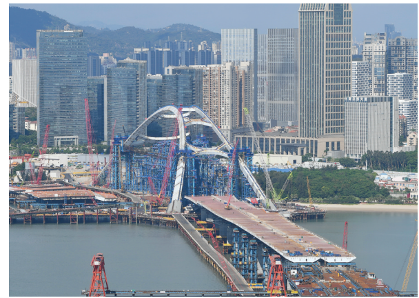
7月8日拍摄的厦金大桥（厦门段）项目观音山互通主线桥拱肋合龙后的场景。
