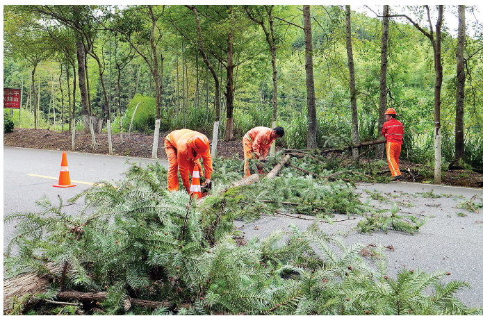
南平市公路事业发展中心建阳分中心抢抓台风来临前窗口期,对辖区国省道开展拉网式隐患排查与整治,全力保障台风期间辖区道路通行安全。图为工作人员对道路边坡一处存在倒伏风险的树木进行砍伐处置。(汤文娟 江洁 刘剑锋 赖思慧 摄)
