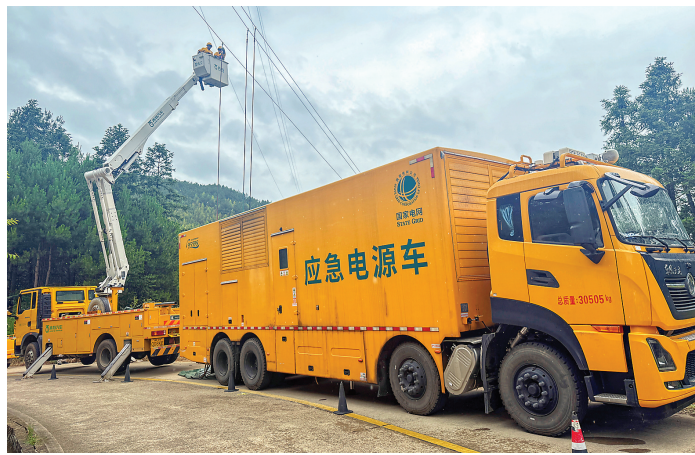
11日,国网浦城县供电公司临江供电所在枫溪乡高海拔易受灾隐患点位提前放置应急发电车,保电人员整装待命,以应对突发险情。(叶凌云 吴建琼 摄)
