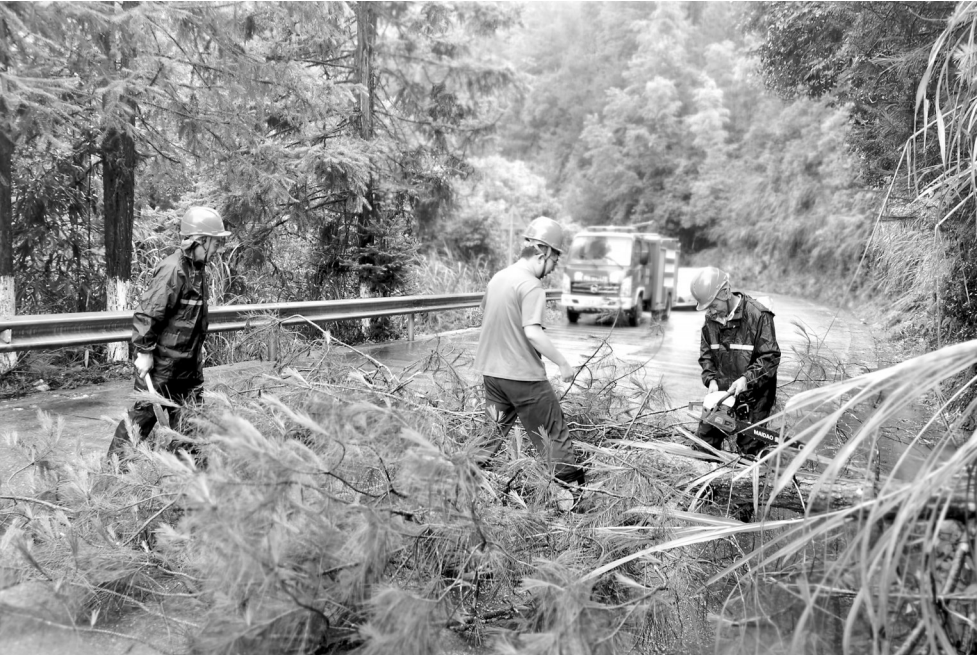
12日上午,武夷山市岚谷乡村干部、应急救援队、包村工作队冒雨开展防汛防台巡查。巡查至沿线一段路时,发现多处枯树倒伏阻断路面,存在较大安全隐患,大家立即使用油锯分段切割,合力将树干、枝丫全部清运,迅速恢复交通。(林李冰 周长岭 摄)
