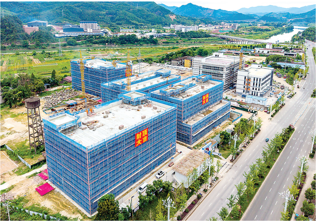
这是近日拍摄的松溪县省级经济开发区“三茶”统筹产业园。该项目总投资5亿元,分两期建设。当前,一期工程已全面转入墙体砌筑、内部装修与水电消防安装施工阶段。项目建成后,将助力当地“三茶”融合产业提质发展。
