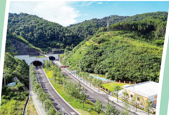
芹溪大街隧道(张行健 摄)
