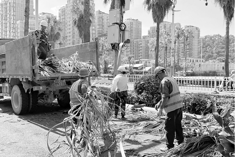
8日,为有效防范台风“白海豚”,全力保障邵武城区道路通行安全与市容环境稳定,邵武市城市管理局组织园林服务中心工作人员开展城区行道树专项排查清理行动。通过对道路两旁树木的枯死枝干、脆弱分叉枝条进行逐一修剪、清理、搬运,及时清除安全隐患。图为专项排查清理行动现场。
