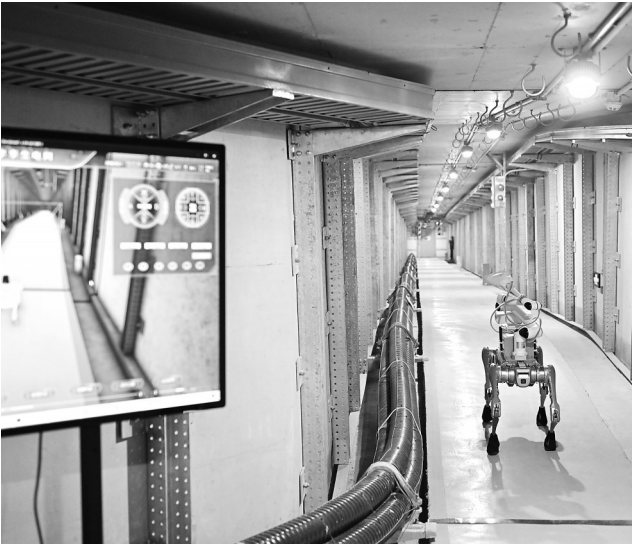
2025年4月15日，四足巡检机器人在雄安新区雄东电缆隧道内巡检。
