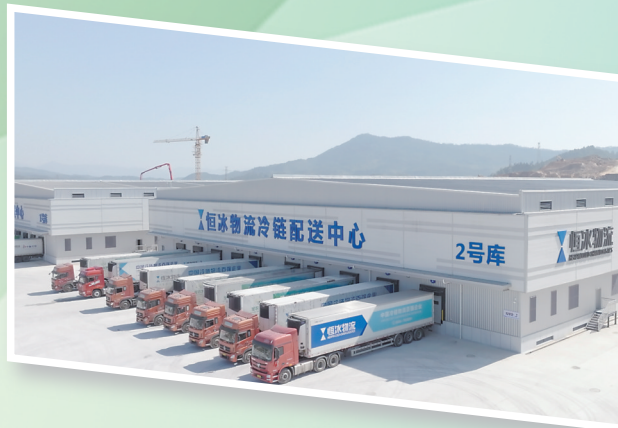
在圣农恒冰冷链物流厂房现场,一辆辆满载的运输车辆接连驶出,开往全国各地。(黄志新 摄)
