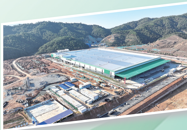
位于武夷新区生态食品产业园的华润怡宝武夷山生产基地项目已进入室内装修阶段,部分设备已进场,预计年内正式投产。(丁健伟 摄)
