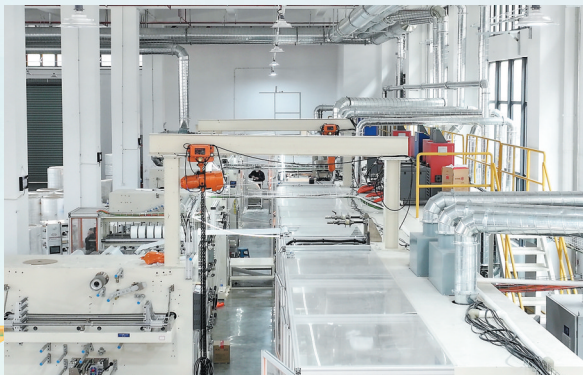
位于武夷新区医卫产业园的金佰康卫生用品项目设备进场
