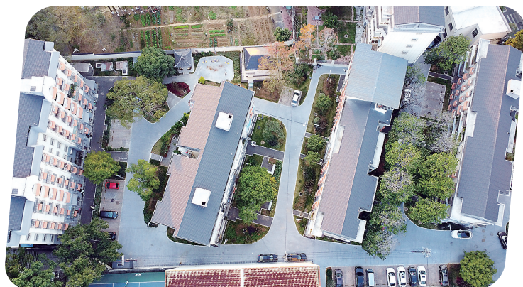
建阳一中宿舍老旧小区项目,通过改造提升小区内基础设施和公共服务设施,进一步优化宜居环境,有效提升了居民的幸福感和获得感。(张莎摄)
