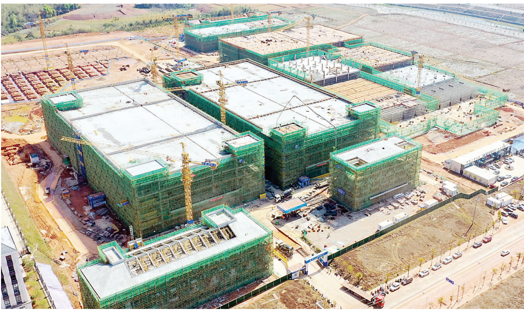
这是日前拍摄的建阳经济开发区标准化厂房及配套基础设施项目建设现场。该项目总投资12亿元,占地面积163亩,总建筑面积约19万平方米,项目建成投产后将进一步扩大当地医卫材料产业集群规模,有利于吸引更多配套关联企业进驻,形成医卫产业集聚区,打响现代医卫产业创新和聚集的工业园区新名片。(张行健 陈颖 林晶 何文 摄)
